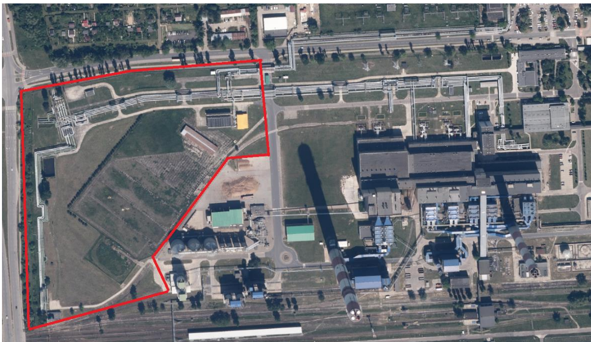
Fot. 1 Teren inwestycji wraz z terenami przyległymi
